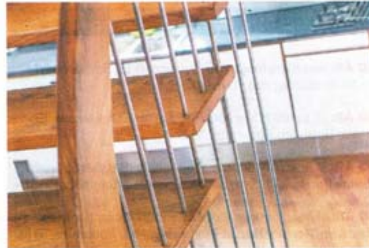
Et udsnit af trappen, der af husets skaber er udformet som en harpen.
